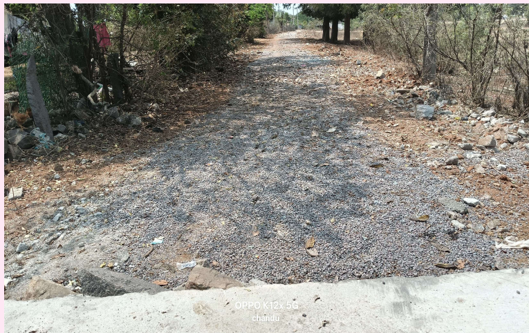
అనంపూర్ణంగా సిసి రోడ్డు నిర్మాణ పనులు.. రోడ్డు పనులు పూర్తి చేయాలని కోరుతున్న విద్యార్థుల తల్లిదండ్రులు..
